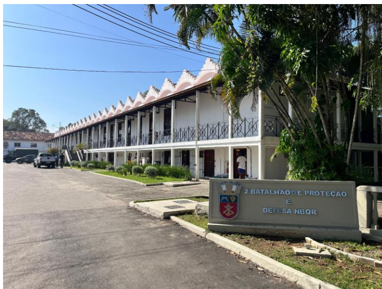
Instalações do prédio do Comando
